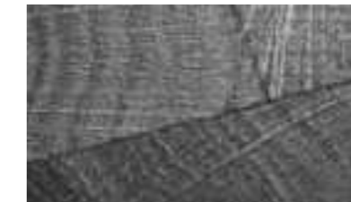
Structure bloc de bois semble aussi massive qu'un arbre fraîchement coupé
