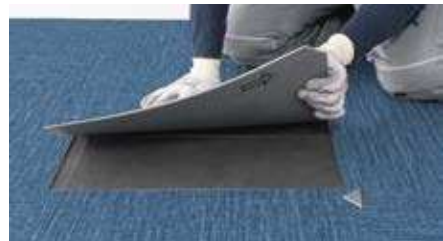
REMPLACEMENT SIMPLIFIÉ D'UNE LAME
